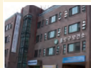
보건소 Sở y tế, trạm xá
